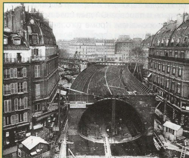
Станция Сен-Мишель строилась на поверхности, и лишь потом ее целиком «закопали» под землю.
